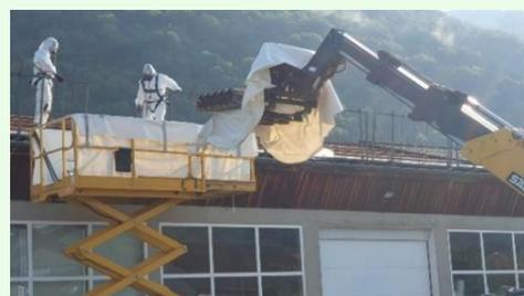
La société MTP Désamiantage a réalisé : la mise en sécurité (filet antichute sous toiture), la protection particules (film polyane), les analyses avant travaux, l'enlèvement et l'évacuation des bacs fibrociment amiantés, et enfin une analyse après travaux pour s'assurer que l'ambiance était saine pour les personnes qui y travaillent ; tout ceci bien sûr, conformément à la réglementation !
