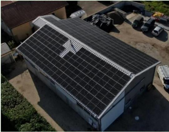
La centrale est composée de 142 modules de 440 Wc, équipés d'un optimiseur de puissance par couple de module.
