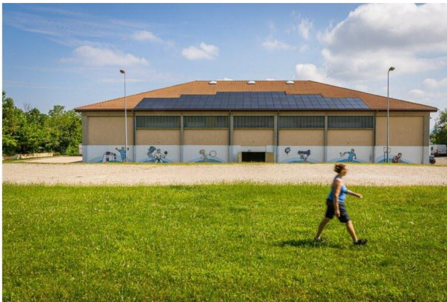
Des panneaux solaires ont été installés sur le toit de la salle de sport de St-Alban-de-Roch par la centrale villageoise NID'énergies. Photo Le DL/Benoît Almeras
