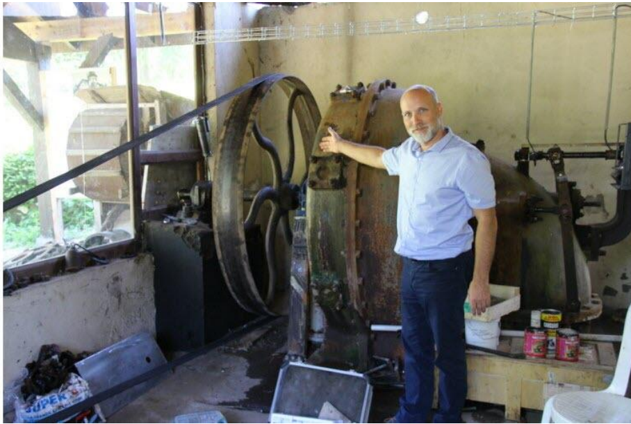
En 1897, la roue accolée au château est remplacée par une turbine et une génératrice, pour produire de l'énergie électrique. Cette turbine vient d'être remise en fonction comme le montre Philippe Martinenghi. Photos Le DL/C.R.
