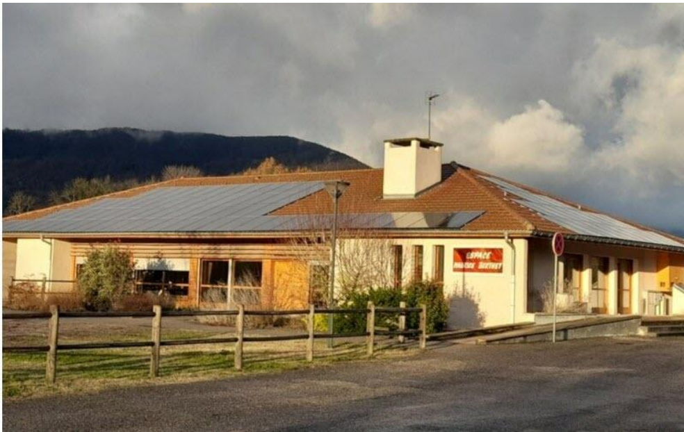
La centrale installée sur le toit de la salle socioculturelle.
