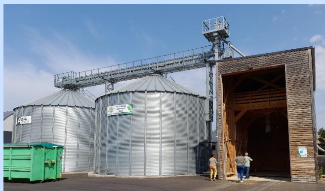
Unité de stockage de granulés à St Laurent en Royans
